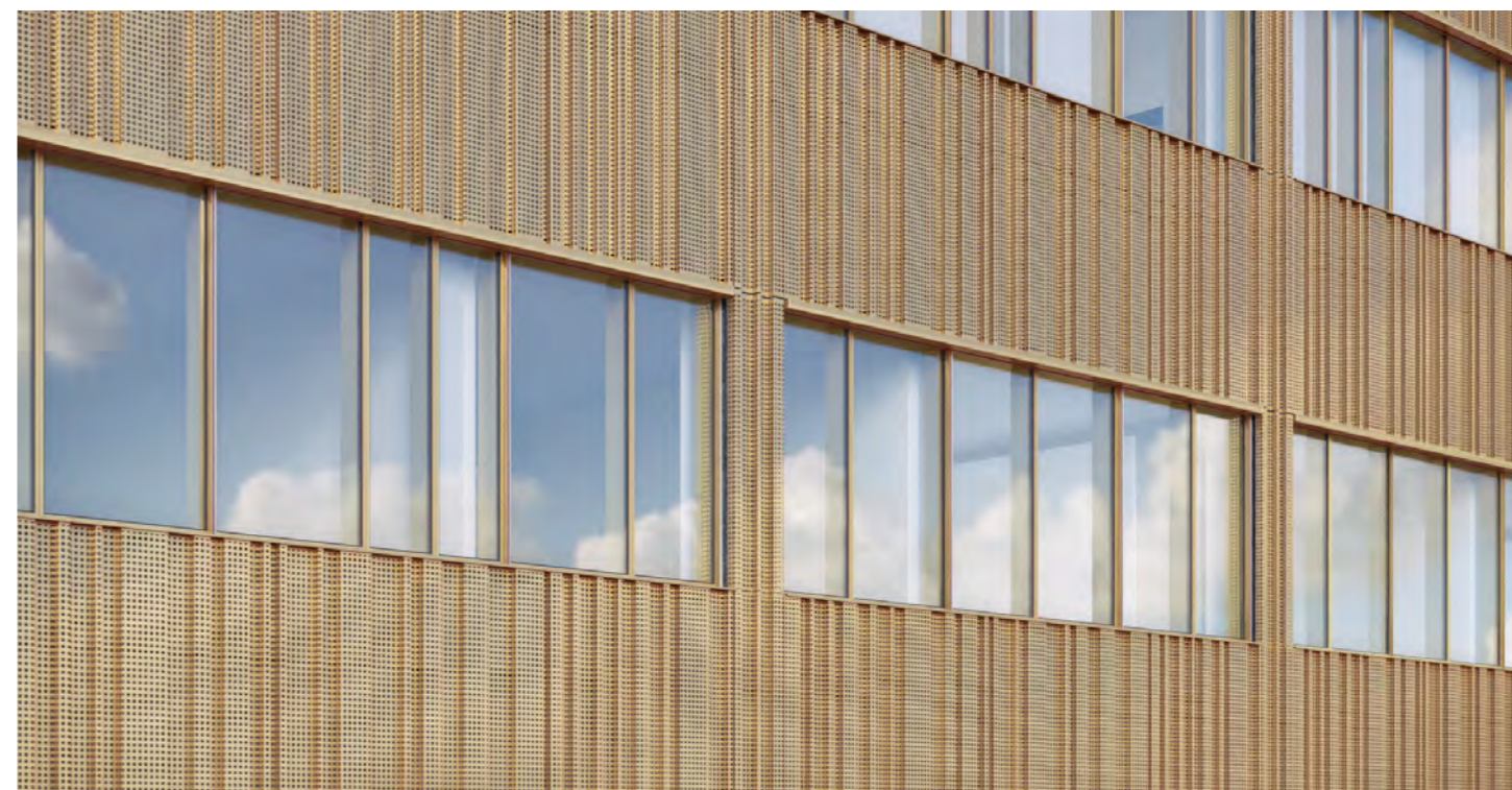
Yttre fasad hus 201 och 202.
